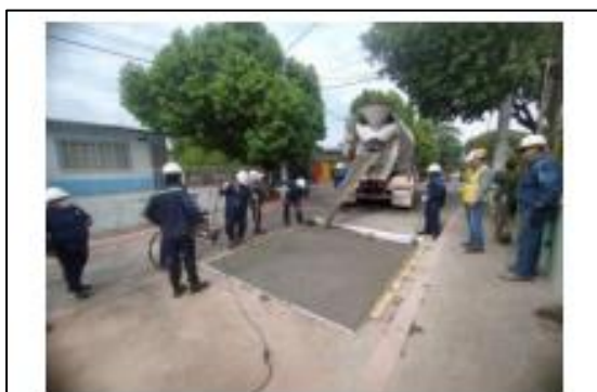
VACIADO DE RESALTO CONCRETO DE 4000 PSI-calle 59 y carrera 36 F instituto 26 se marzo sede D: Alcázar
