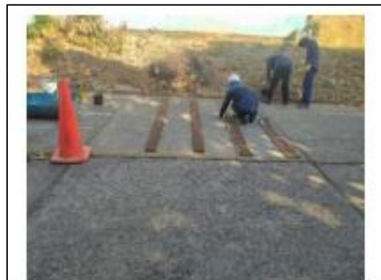
CONSTRUCCIÓN DE BANDA SONORA - calle 59 y carrera 36 F instituto 26 se marzo sede D: Alcázar
