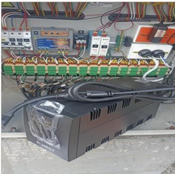
Suministro e Instalación del sistema de Respaldo UPS de 2 KVA
